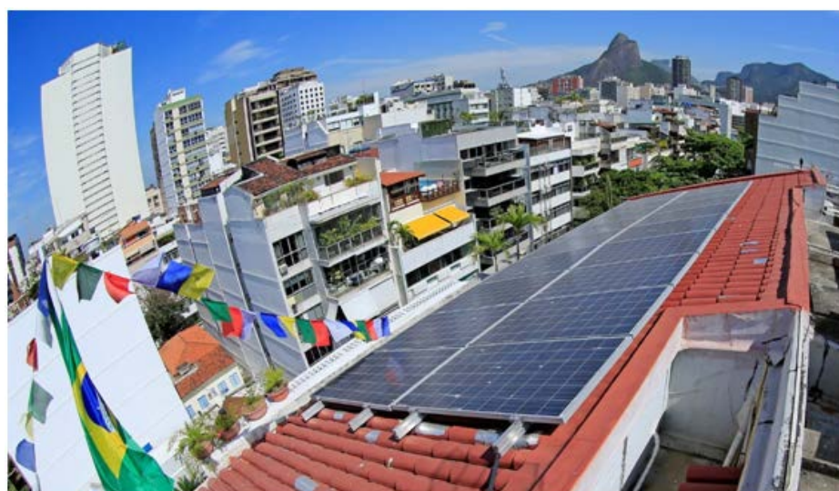
Figura 5 - Energia solar em cobertura
