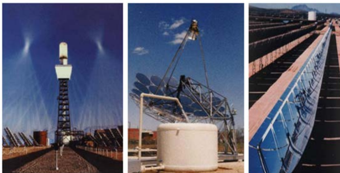
Figura 2 – Sistemas Torre Central Disco-Parabólico e Cilindro-Parabólico de geração de energia Heliotérmica
